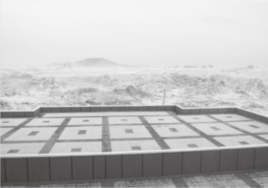
病院の屋上近くまで押し寄せた津波
